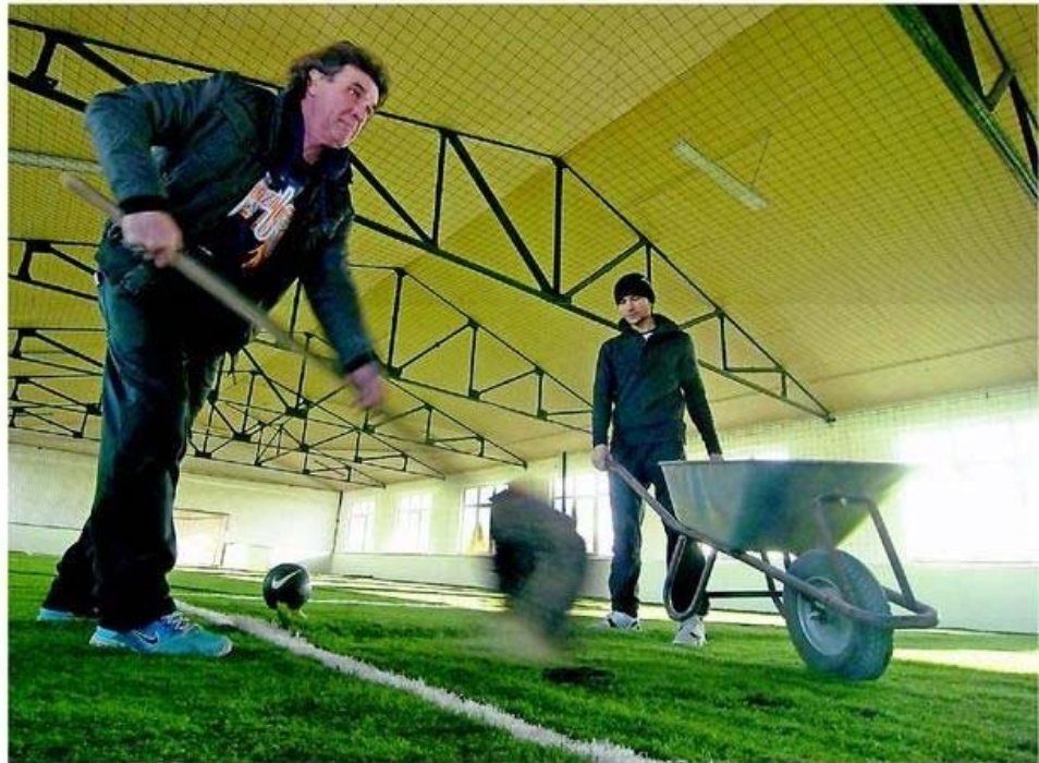
Die letzten Arbeiten an der neuen Socceranlage erledigt Mieczyslaw Zalewski (l.) mit seinem Sohn Marcel. Hier bringen sie das Granulat in den Soccerfeldboden ein. RP-FOTO: GERHARD SEYBERT
